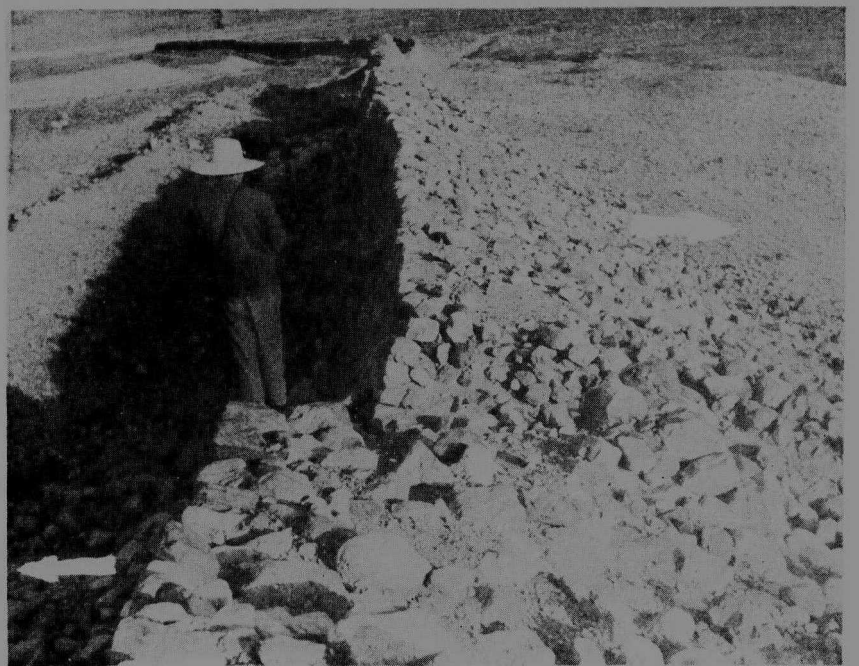
照片 6 银川盆地西北部红果子附近,明代长城被北北东向第四纪断层错开,右旋水平错距1.5米,东侧下降,垂直错距0.9米, (镜头向北,1965年摄)。
