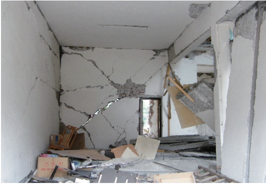
图 6 小鱼洞镇阶地前缘房屋破坏严重
