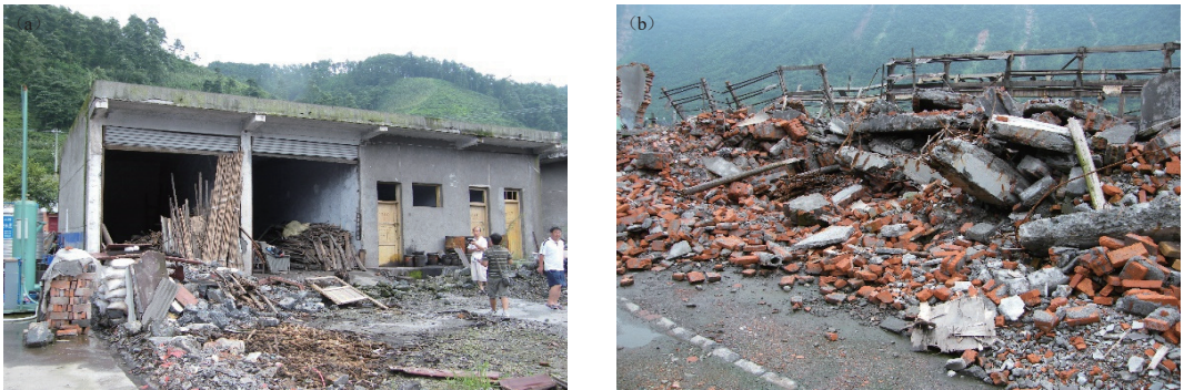
图 3 河流阶地后缘和前缘的房屋震害程度
