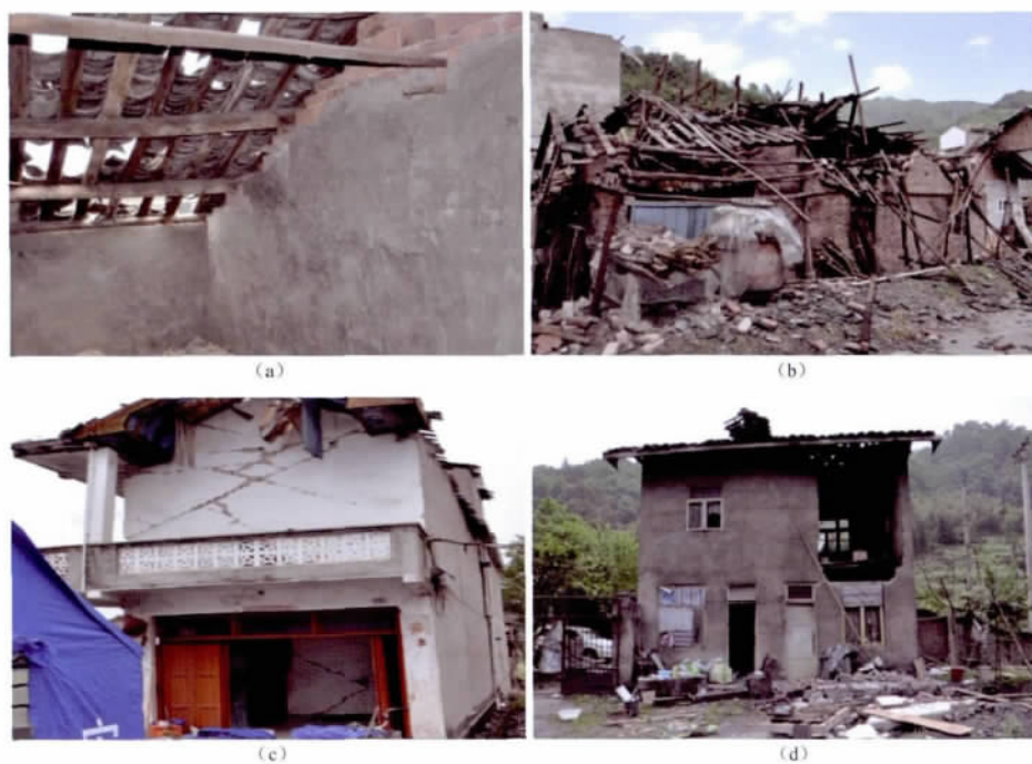
图 4 砌体-木屋架房屋震害. (a) 掉瓦; (b) 屋架坍塌; (c) 墙体严重开裂; (d) “12”厚墙体外闪倒塌
