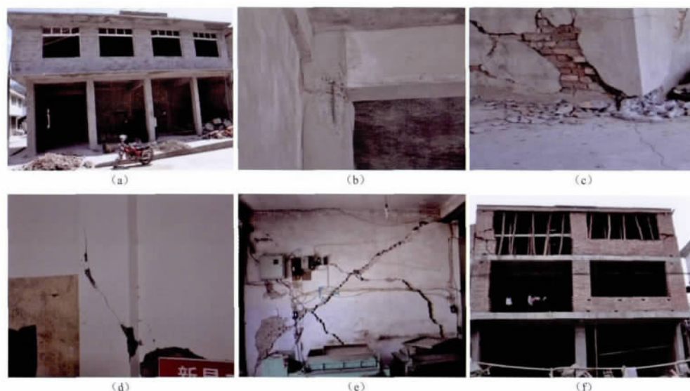
图 6 砌体-框架混合结构震害。(a) 受损的底框结构;(b) 底层柱顶破坏;(c) 底层柱底破坏; (d) 底层柱中剪切裂缝;(e) 底层填充墙破坏;(f) 上部砌体结构破坏
