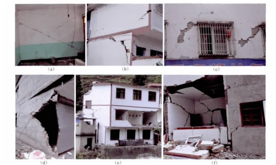
图 5 砖混结构震害. (a) 承重墙剪切裂缝; (b) 承重墙严重破坏; (c) 窗间墙剪切裂缝; (d) “18”厚承重墙局部垮塌; (e) 非承重墙外闪倒塌; (f) 毁坏的砌体结构
