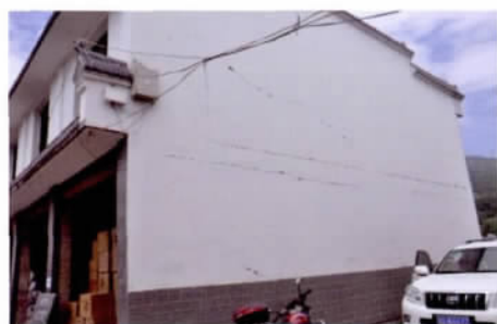
图 7 框架结构填充墙轻微裂缝
