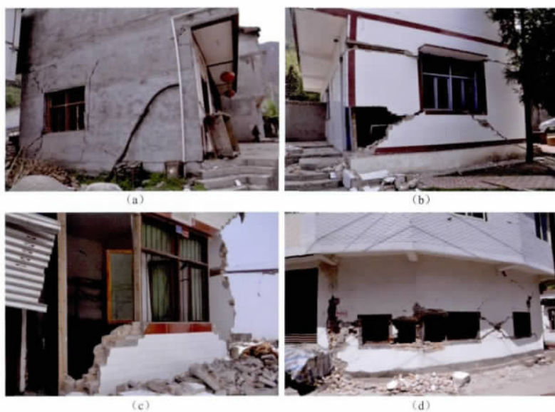
图 9 不合理开窗造成的震害加重. (a) 承重墙不合理开窗; (b) 承重墙开窗过大; (c) 非承重墙开窗过大; (d) 墙体开窗过多造成短柱效应
