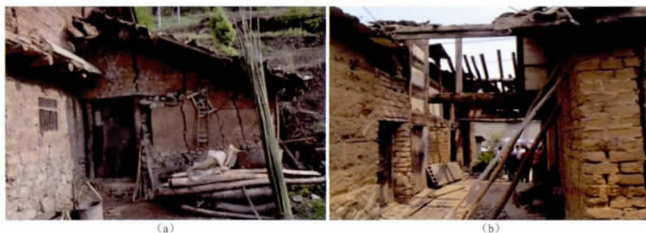
图 2 土木结构房屋的震害。(a) 墙体开裂;(b) 木屋架塌陷
