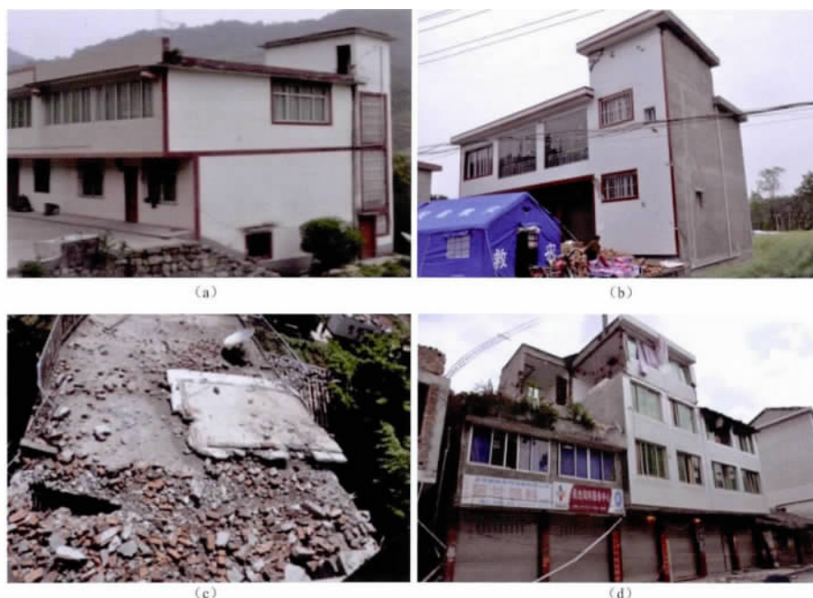
图 11 突出屋顶的楼梯间和加层的破坏。(a) 屋顶楼梯间墙体开裂;(b) 屋顶楼梯间墙体开裂; (c) 屋顶楼梯间垮塌砸坏主体结构;(d) 屋顶加层结构发生墙体闪落
