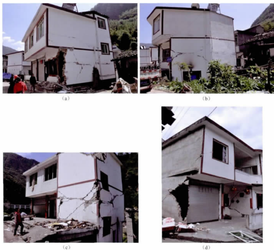
图 10 不规则布置造成的震害加重. (a) 头重脚轻; (b) 平面呈多边形; (c), (d) 平立面均不规则
