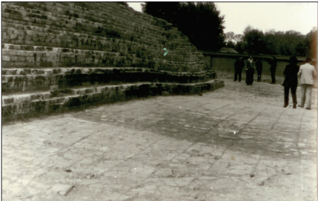
图 1 辽大塔北侧塔基的波浪状 变形照片(镜向 SWW)
