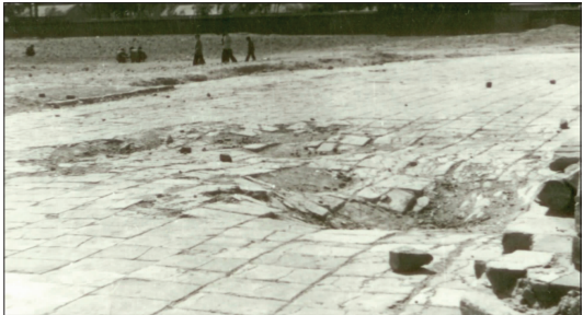
图 2 辽大塔东侧由于塔上崩落的大砖砌体砸入 地面形成深达 47 cm 的坑照片(镜向 SE)
